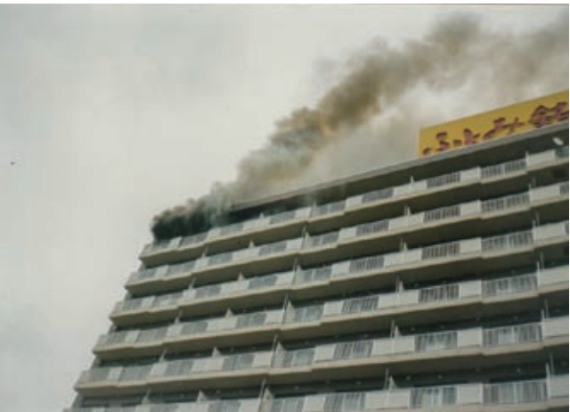
平成 9 年 8 月 11 階共同住宅火災
