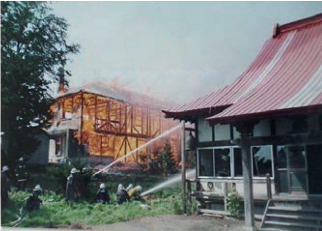
平成 8 年 9 月 13 日 中小屋小学校火災
